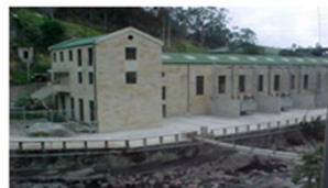
Salto I – 56.8 MW HPP - Rimonar 1998
