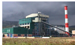
Termopaiva IV – 152 MW CCPP - 1996
