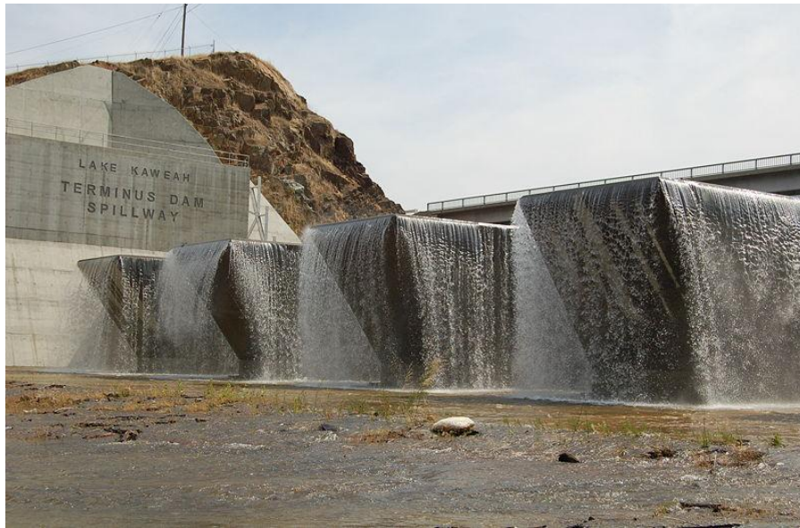
Vertedero de diques fusibles
