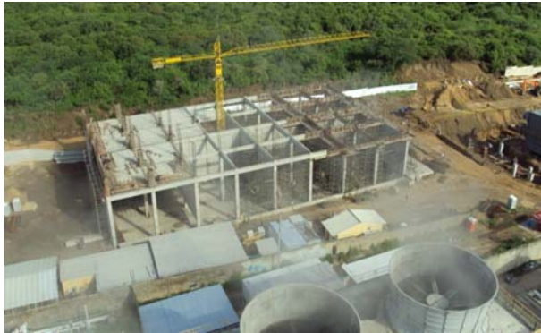
Torre enfriamiento – Construcción de estructura interior en concreto
