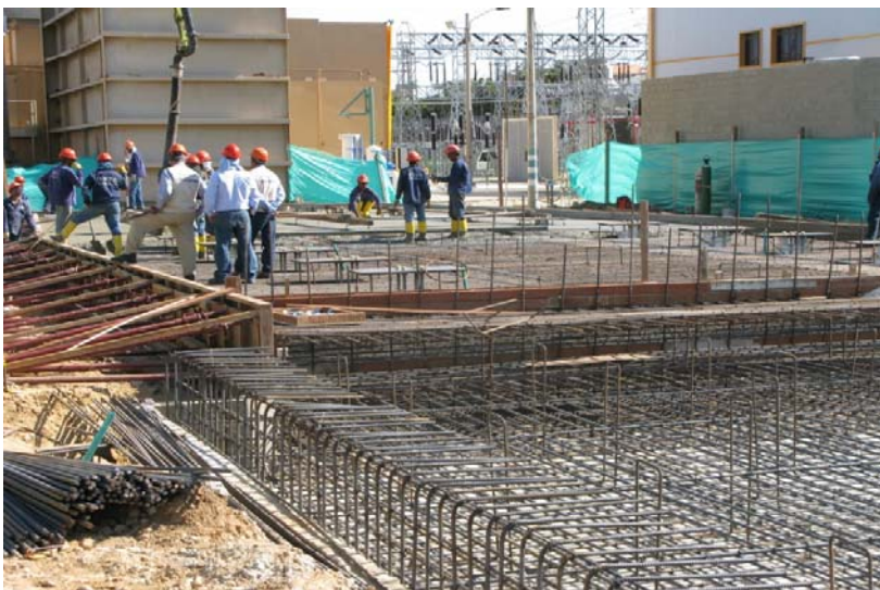
Caldera HRSG 2 – Armado de refuerzo para losa de piso
