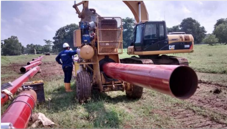
Imagen: Doblado de tubería
