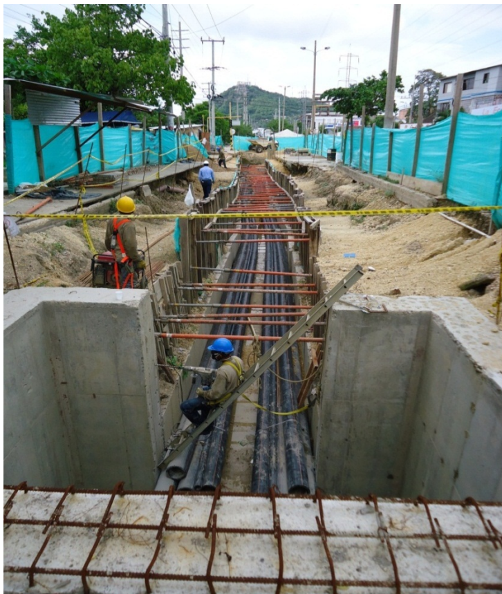
Zanja a cielo abierto para llegada de tubería a la caja de empalme No.1
