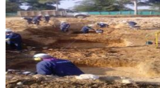
Excavación zapata cuarto de control
