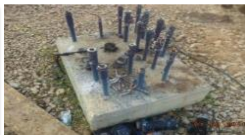
Desmantelamiento de caja
