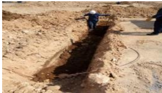
Tendido de cable desnudo
