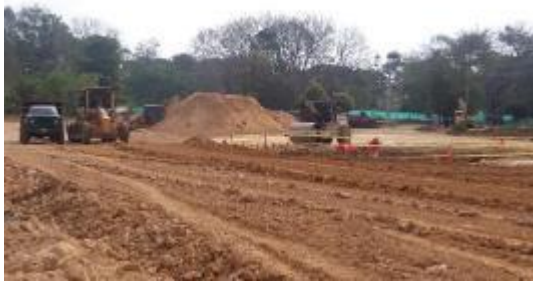
Nivelación y compactación
