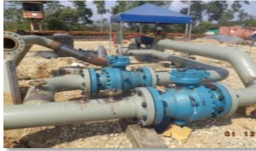
Montaje de tuberías
