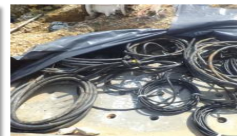
Desconectado y halado de cables
