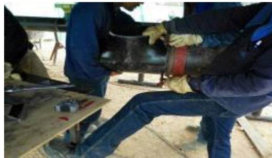
Prefabricado de tubería
