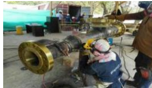
Soldado de tubería
