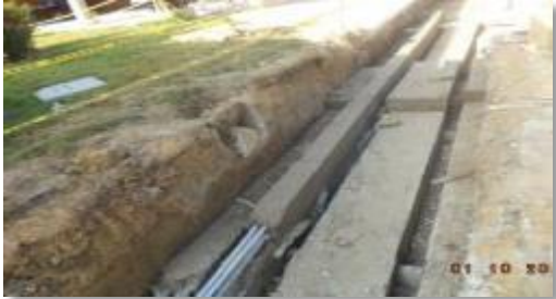
Fundida de concreto
