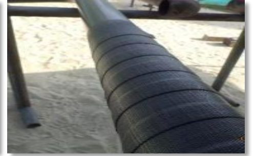
Recubrimiento de tubería
