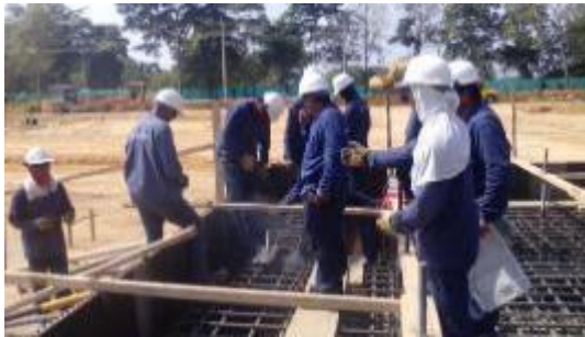
Instalación de pernos de anclaje
