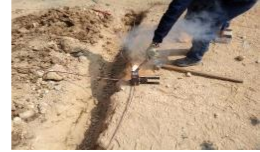
Soldadura exotérmica
