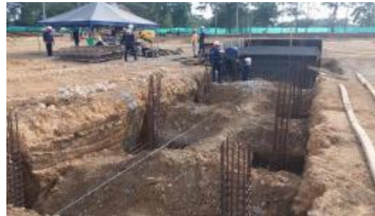
Instalación de acero en zapata
