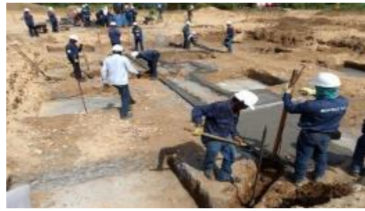
Excavación y relleno manual
