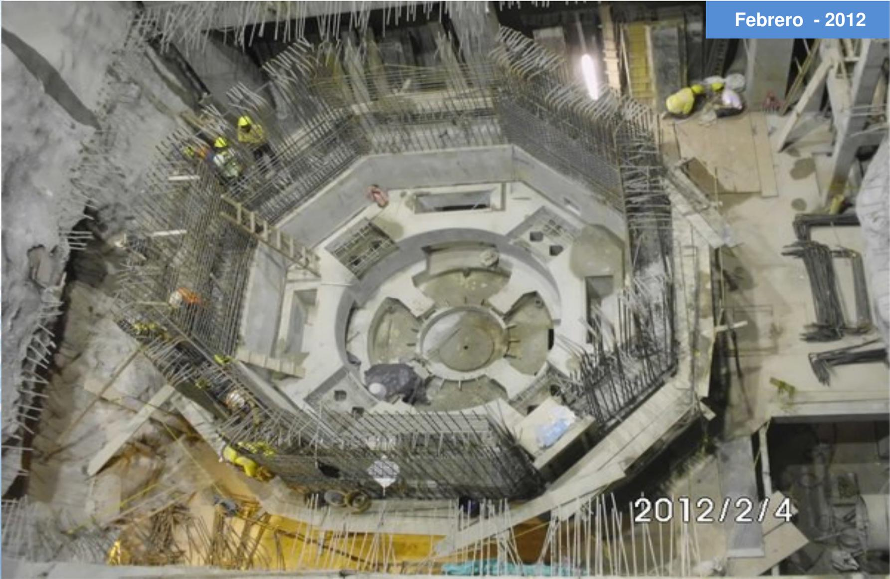
Instalación de Refuerzo Octógono y Fundición Primer Tramo de Muro
