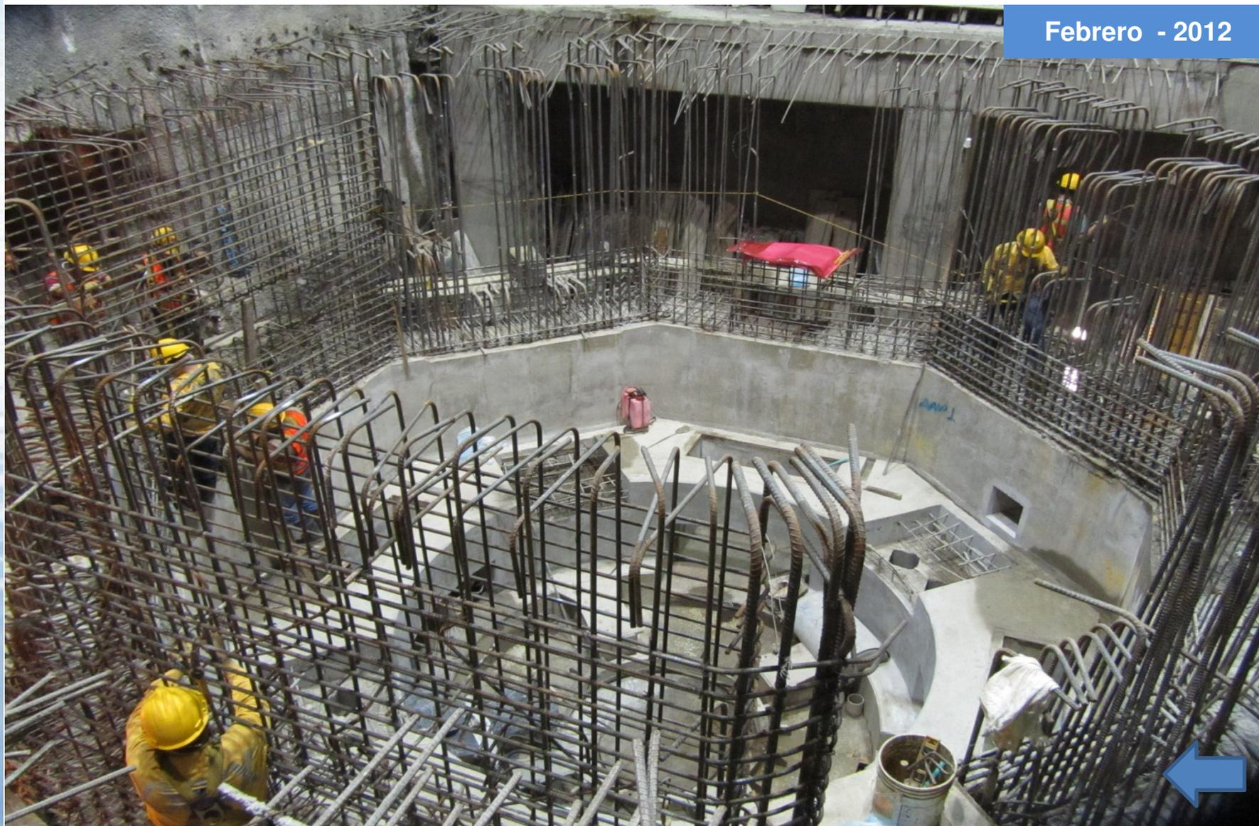
Instalación de Refuerzo Octógono y Fundición Primer Tramo de Muro
