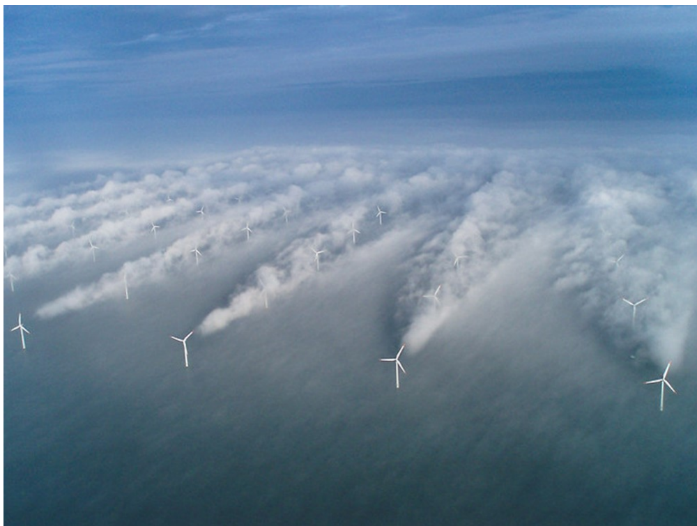
Figura 5: Parque eólico de "Horns Rev". En la imagen se evidencia que las turbinas de las últimas filas (sotavento) están afectadas por varias turbinas. Imagen original tomada de [11]
