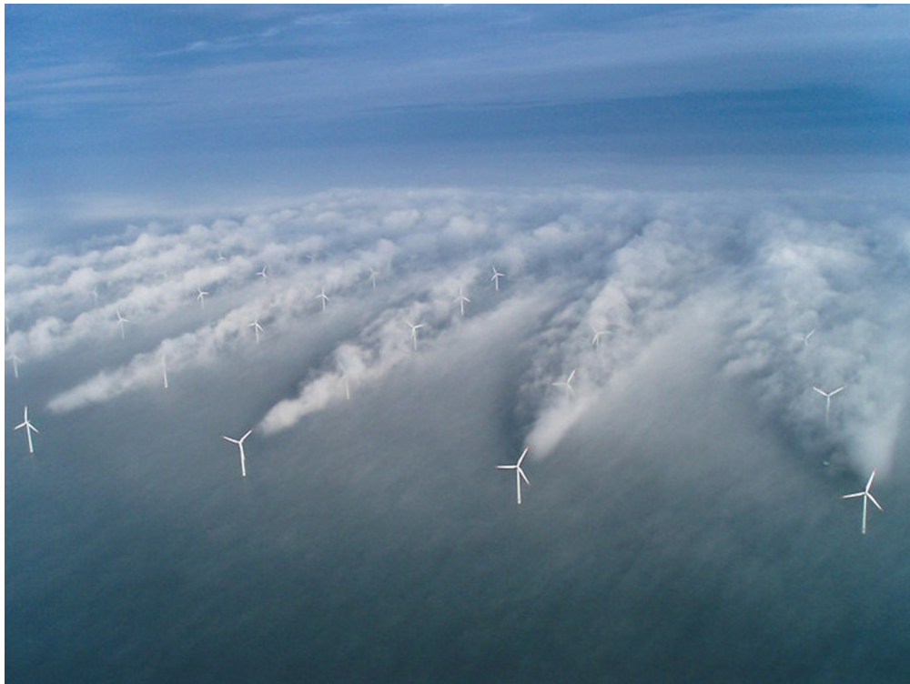
Figura 21: Parque eólico de "Horns Rev". En la imagen se evidencia que las turbinas de las últimas filas (sotavento) están afectadas por varias turbinas. Imagen original tomada de [34]
