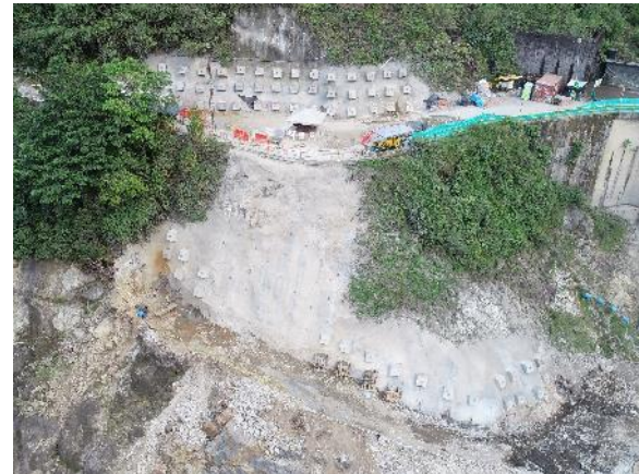
Soporte talud pozo de carga
