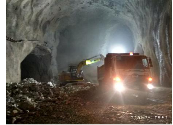
Cámara de válvulas
