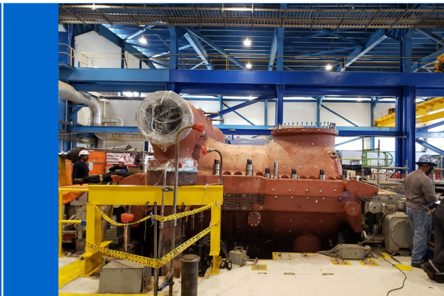
Carcasa de Turbina. Sección HP
