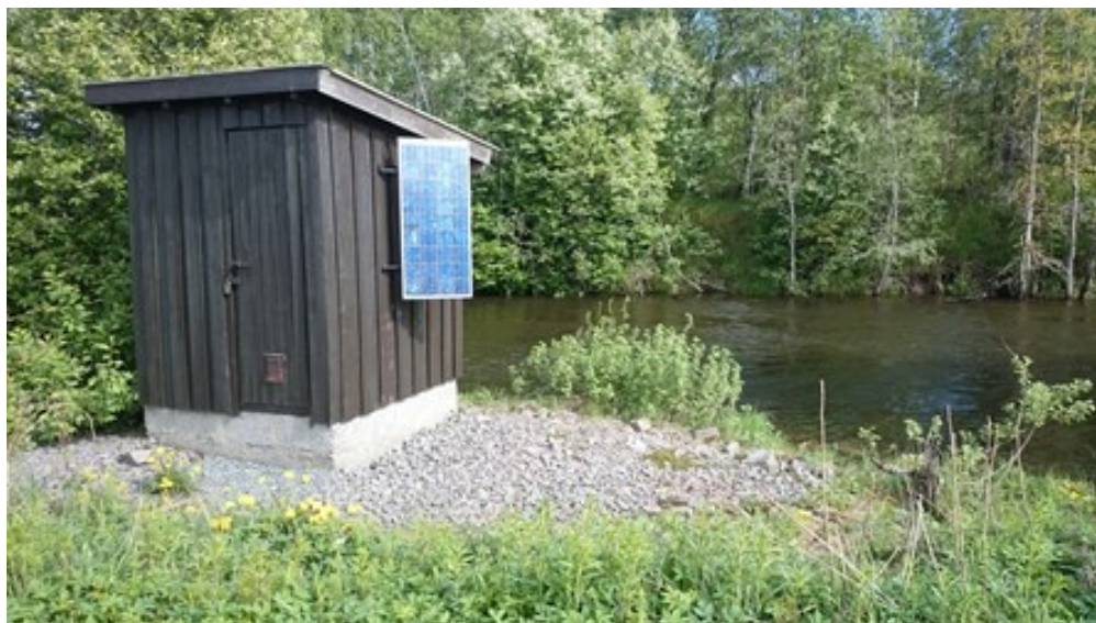
Figura 2: Estación de aforo de caudal en cabina [45]
