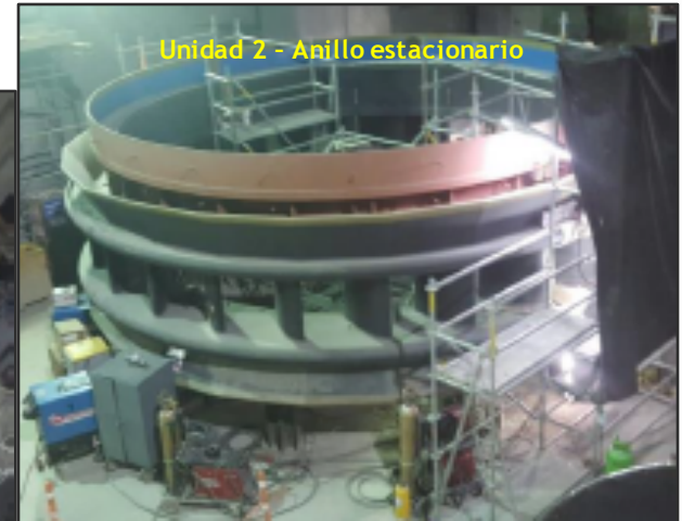
Unidad 2 - Montaje de elementos embebidos en concreto: Avance 32%
