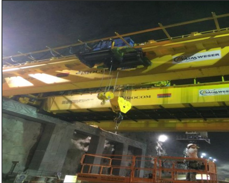
Punto grúa N°2 Casa de máquinas - Montaje
