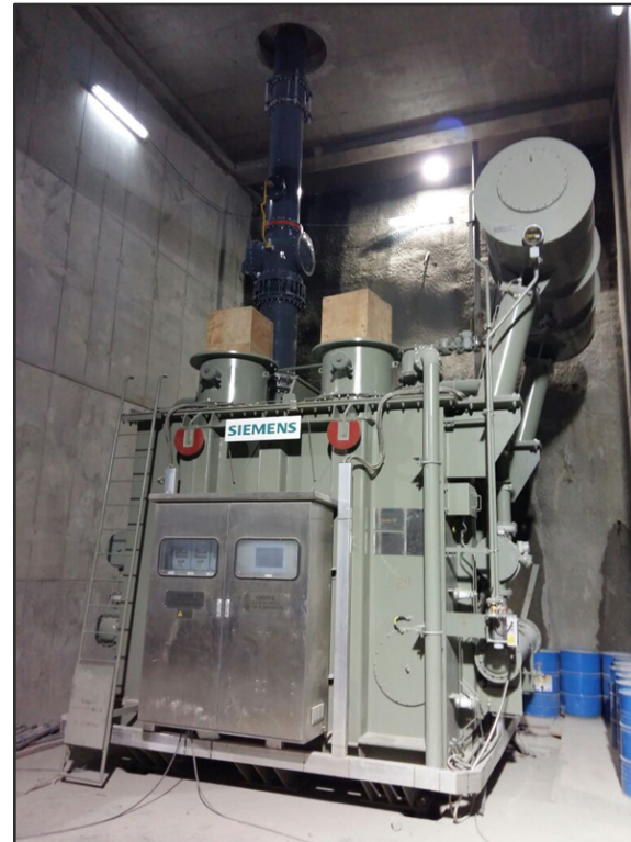
Montaje de transformadores etapa I Compartimentos 4 y 3 del módulo GIB instalados
