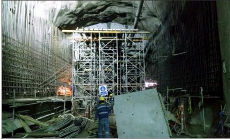
Túnel de aspiración 2 - Concretos
