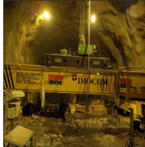
SAD – Montaje del punto grúa
